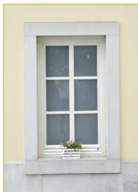
Forme: i serramenti finestra avranno stessa forma e specchiatura di quelle precedentemente autorizzate esistenti, con profili semplici, relativamente sottili e divisi in 2, 4 o 6 specchiature. Le finestre più piccole presentano una singola lastra.
