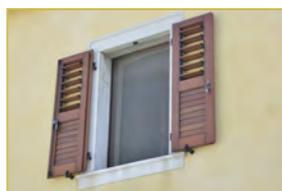
Forme: oscuranti a doppia anta con finitura a doghe verticali o orizzontali piene, con lamelle pieghevoli sull'intero oscurante o porzione, con alternanza lamelle/specchiatura piena (anche lavorata).
