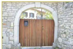
Forme: ante piene costituite da doghe verticali, orizzontali o da specchiature cieche. Le tipologie dovranno rispettare le caratteristiche locali, riferite in particolare a quelle dei borghi rurali carsici.
