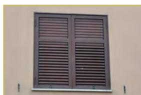
Forme: doppia anta con finitura a doghe verticali o orizzontali piene, con lamelle pieghevoli sull'intero oscurante o porzione, con alternanza lamelle/specchiatura piena (anche lavorata). Le tipologie dovranno rispettare le caratteristiche locali, riferite in particolare a quelle dei borghi rurali carsici.
