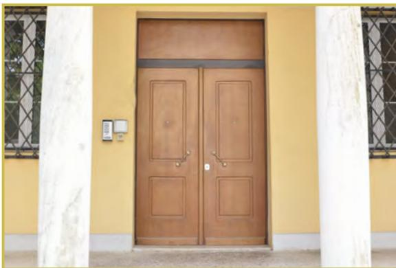
Forme: costituite da singola o doppia anta. Possono avere specchiature completamente cieche o miste. Devono integrarsi con il contesto paesaggistico ed ambientale, interpretando in chiave contemporanea le caratteristiche costruttive e tipologiche consolidate dell'architettura degli edifici e fabbricati prospettanti il mare in questa zona, utilizzando i materiali propri della tradizione.
