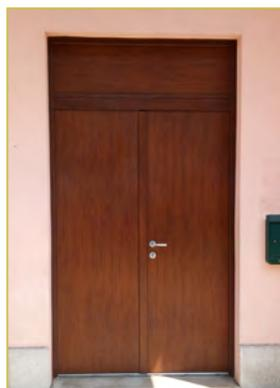
Forme: singola o doppia anta. Possono avere specchiature completamente cieche o miste. Le tipologie dovranno rispettare le caratteristiche locali, riferite in particolare a quelle dei borghi rurali carsici.
