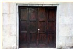
Forme: ante piene costituite da doghe verticali, orizzontali o da specchiature cieche. Devono integrarsi con il contesto paesaggistico ed ambientale, interpretando in chiave contemporanea le caratteristiche costruttive e tipologiche consolidate dell'architettura degli edifici e fabbricati prospettanti il mare in questa zona, utilizzando i materiali propri della tradizione.
