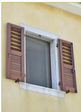
Forme: oscuranti a doppia anta con finitura a doghe verticali o orizzontali piene, con lamelle pieghevoli sull'intero oscurante o porzione, con alternanza lamelle/specchiatura piena (anche lavorata). Devono integrarsi con il contesto paesaggistico ed ambientale, interpretando in chiave contemporanea le caratteristiche costruttive e tipologiche consolidate dell'architettura degli edifici e fabbricati prospettanti il mare in questa zona, utilizzando i materiali propri della tradizione.
